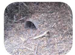
Curage canal des Alpines avant après
