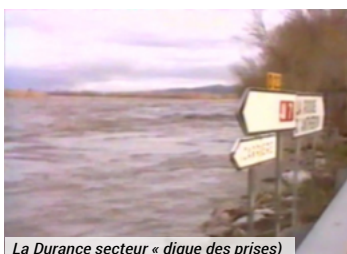
La Durance secteur « digue des prises »
